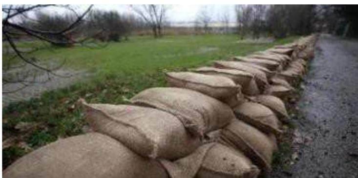
Figura 60 - Barriera temporanea antiesondazione in sacchi di sabbia
