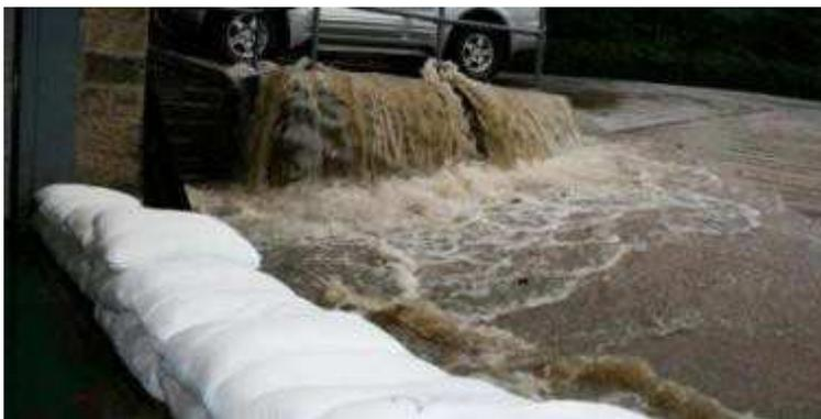
Figura 61 - Barriera temporanea in sacchi riempiti con materiale sintetico assorbente
