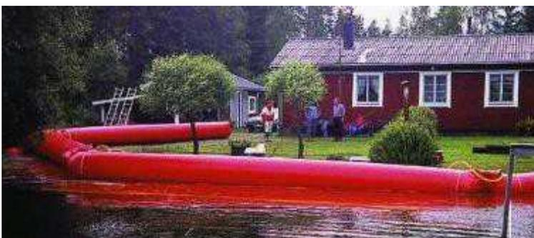
Figura 62 - Barriera temporanea antiesondazione riempita ad aria
