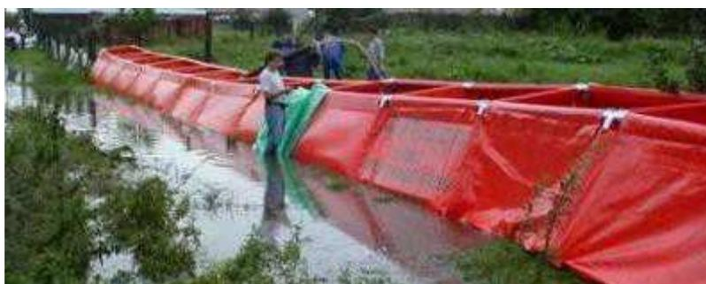
Figura 63 - Barriera temporanea antiesondazione riempita ad acqua
