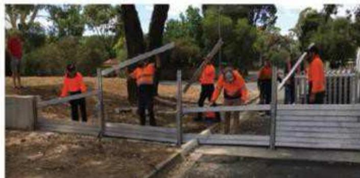
*Figura 65 - Barriera temporanea modulare con pilastri e panconi manuali in alluminio*
