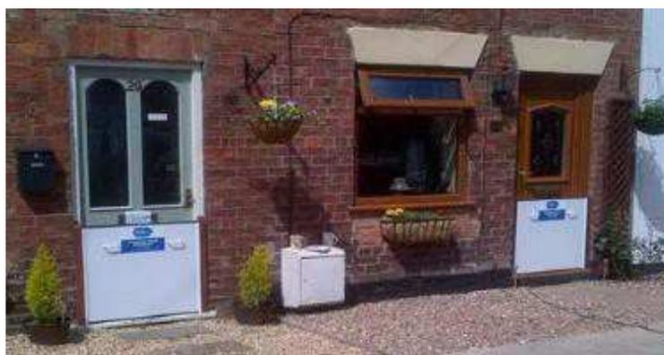
*Figura 67 - Paratoie manuali a protezione di porte di ingresso*
