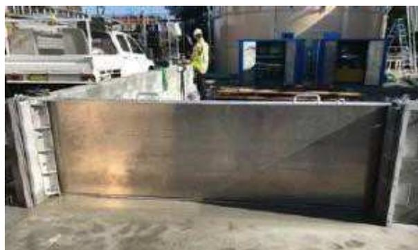
*Figura 66 - Paratoia di chiusura a scorrimento orizzontale per un cancello a tenuta idraulica*
